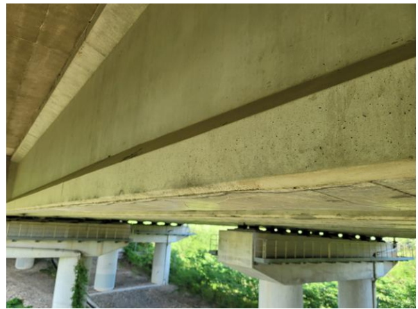
PSC Girder 전경
