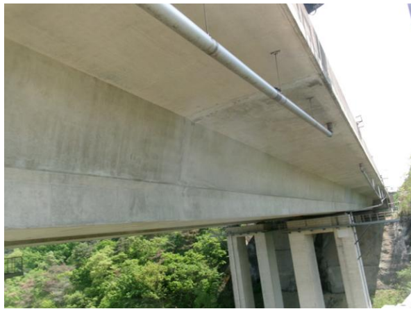
PSC BOX 외부 전경
